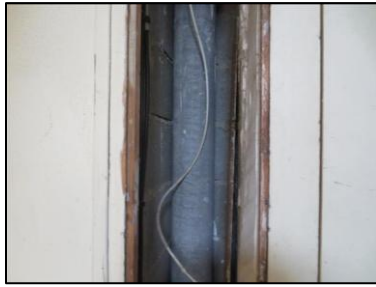
Photo N° 1071 AMIANTE CIMENT - -PLACARDS TECHNIQUES -1 à +3 Conduits de fluide Chute E.P.(Fibres-ciment)
